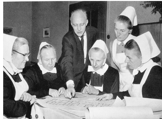
Planung für das Schwesternwohnheim, erbaut 1963. Martin Zöckler mit Diakonissen über den Plänen.
